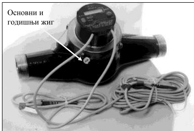
Слика 2. Места постављања жига на мерило топлотне енергије
